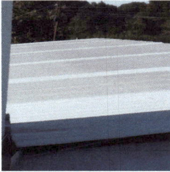
Foto 1: Cubiertas de láminas de techo de aulas.
