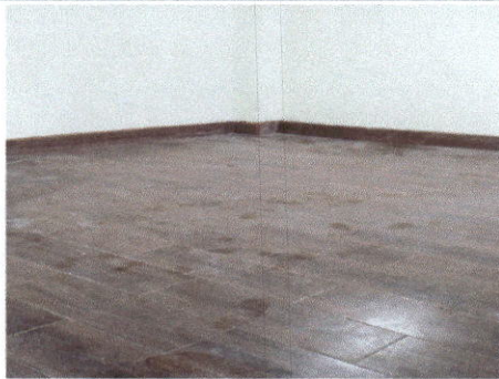
Foto 3: Piso cérmico de cocina.
