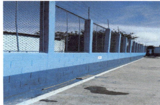
Foto 4: Muros exteriores e interiores pintados.
